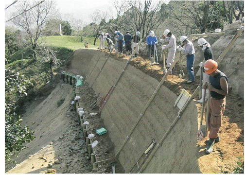
写真II-30 大野城跡土塁の復旧整備状況 (太宰府市)
