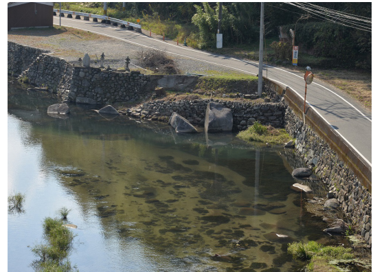
写真13 女男石護岸施設(朝倉市)
