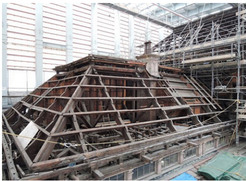
写真II-15 門司港駅修理状況（北九州市）
